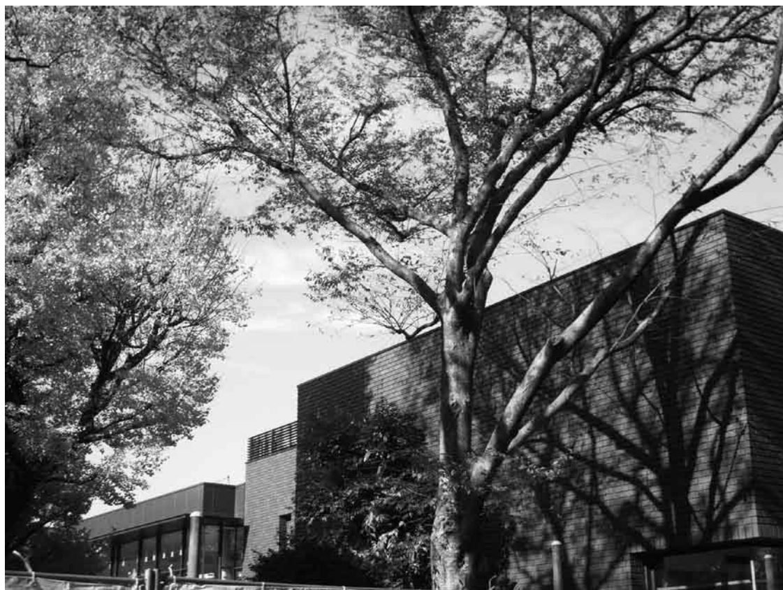
改修工事完了間近の東京都美術館 (2011年12月撮影)
